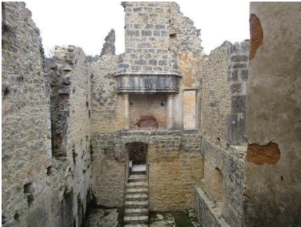
Et cheminée en suspend dans le vide
